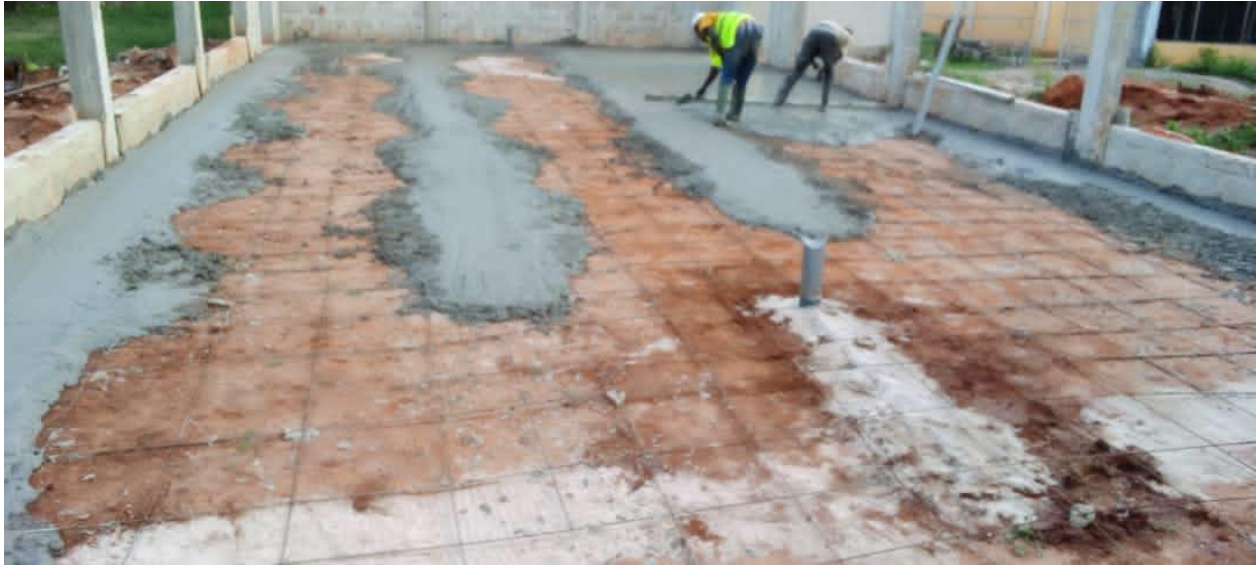
Photo 8 : Photos montrant les travaux de dallage au sol
