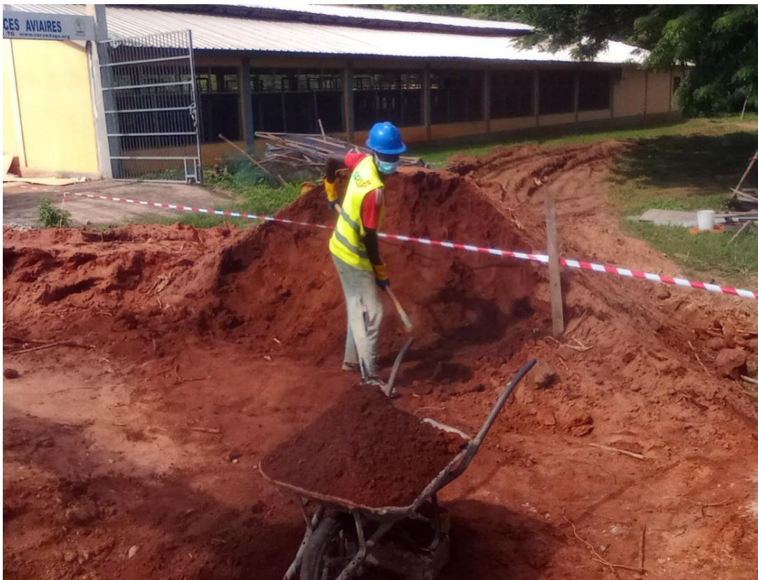
Photo 7 : Photo montrant les travaux de remblais
