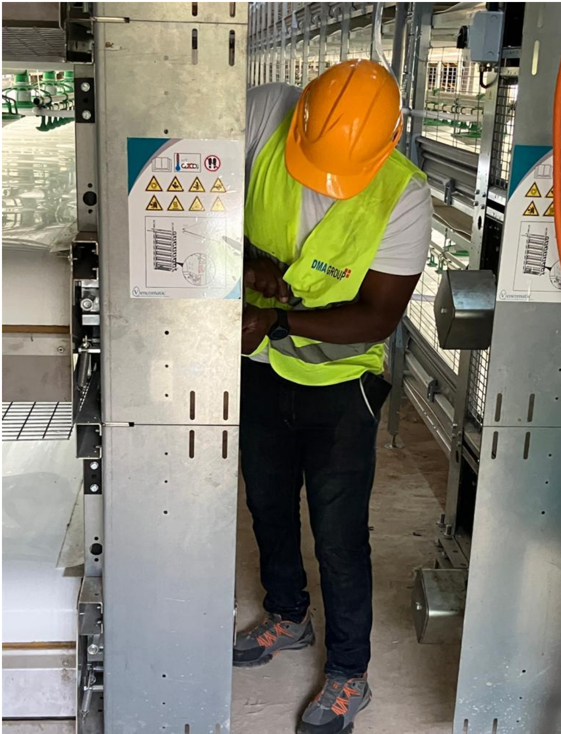
Photo 10 : Photos montrant le montage de VANCOMATIC
