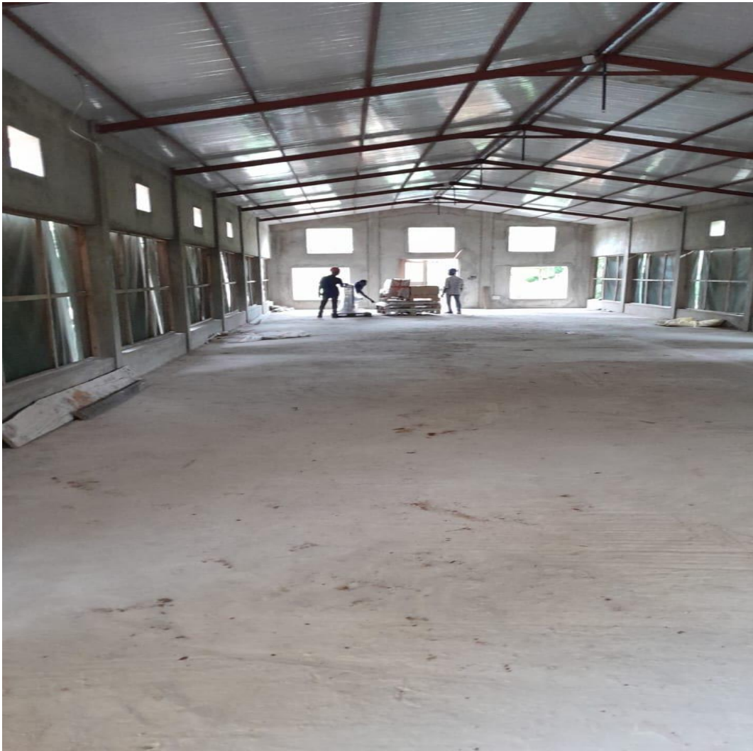
Photo 9 : Photo montrant l'intérieur du PATIO
