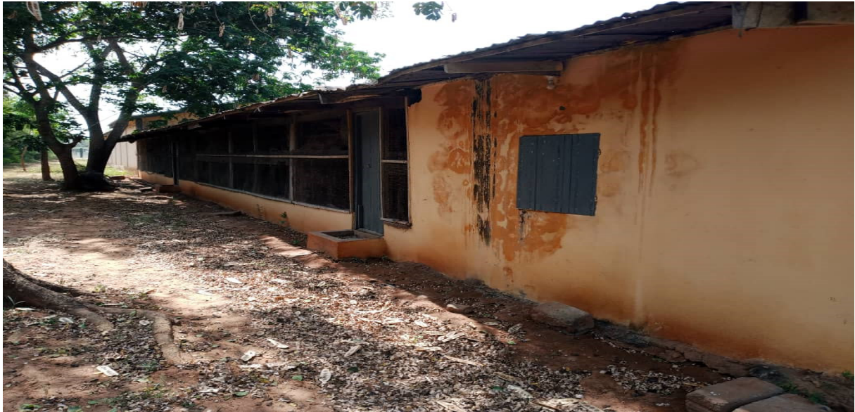
Photo 1 : Photo du local du PATIO à réhabiliter
